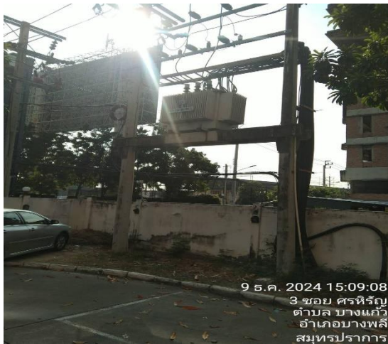
รูปที่ 2.4.5-1 หม้อแปลงไฟฟ้า ชุดที่ A
